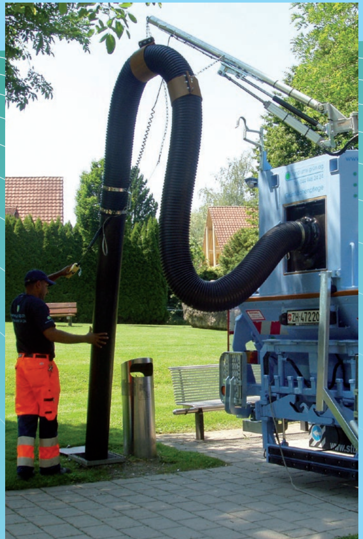
Leeren eines «Clean City»-Unterflurbehälters ▲
